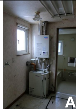
ボイラー等が混在し雑然とした印象の既存洗面室
